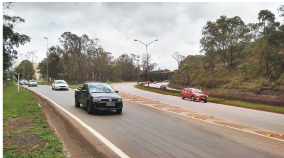
TREVO PARA OURO PRETO | NO HORÁRIO DE PICO, O FLUXO É DE 1.800 VEÍCULOS/HORA NO SENTIDO RIO/BH
