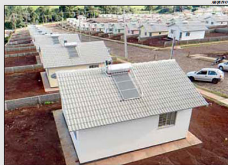
Instalação de coletores representa medida de eficiência energética
